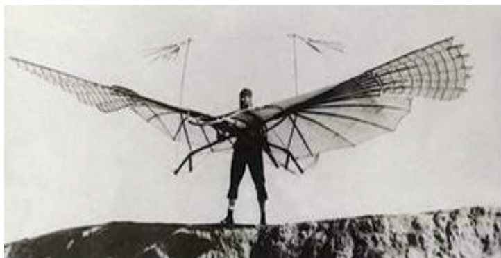
En 1894, l'allemand Otto LILIENTHAL, parvient à mettre au point un planeur capable de voler sur 400m . Ses prototypes étaient réalisés à partir de nervures de bambous entoilés de coton. Il fait aménager une colline de 30m près de chez lui. Il effectua plus de 2500 vols planés.
